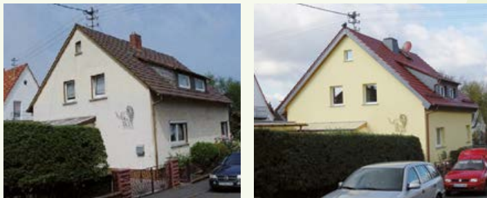
■ Das Gebäude vor und nach der Sanierung
